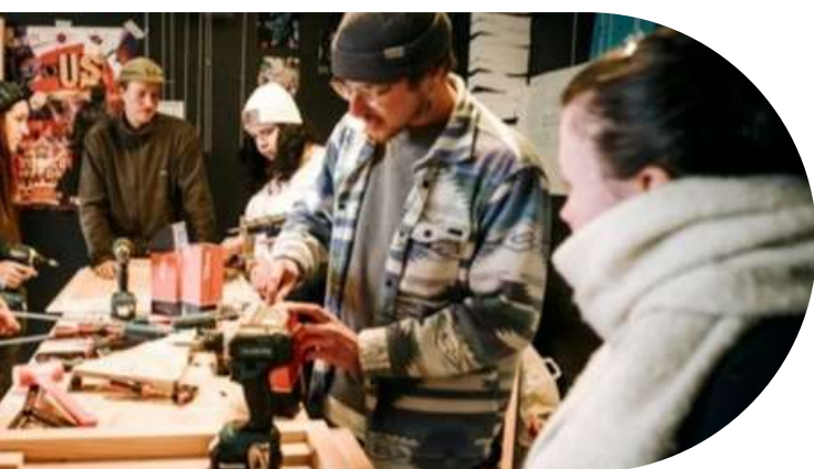
Construction du MoMo - Mai 2025
